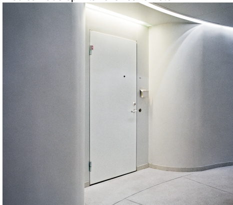
Samtliga lägenhetsdörrar i Turning Torso är S43.
